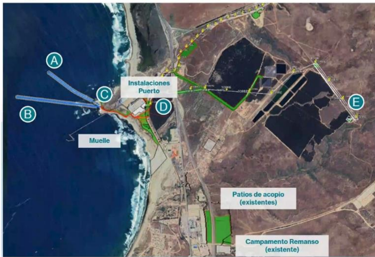
Vista general Obras Puerto: Obras marinas y nueva desaladora
